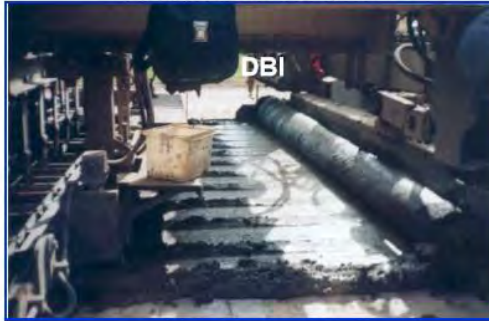
COLOCACION DE PASADORES AUTOMATICA
