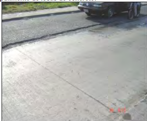
Fotografía 14. Vista típica de una vía con pulimento de losas de concreto.
