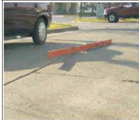
Fotografía 8. Vista típica de una separación de junta longitudinal asociada a un hundimiento.
