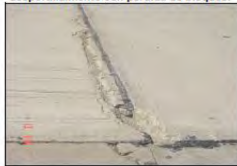
Fotografía 10. Vista típica de un desportillamiento con pérdida de bloques.
