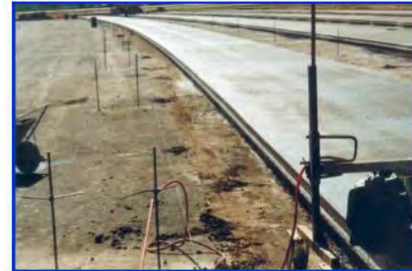
FAJAS DE PAVIMENTACION TERMINADAS
