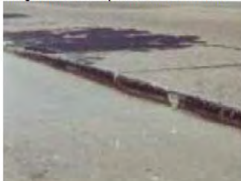
Fotografía 15. Vista típica de escalonamiento
