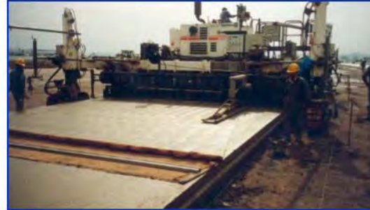
TERMINACION SUPERFICIAL DE CALZADA
