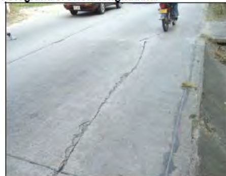
Fotografía 3. Grieta longitudinal
