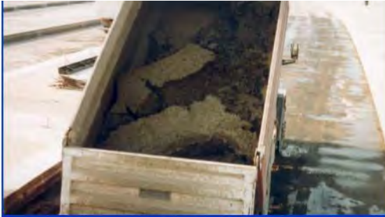
DESCARGA DEL CONCRETO
