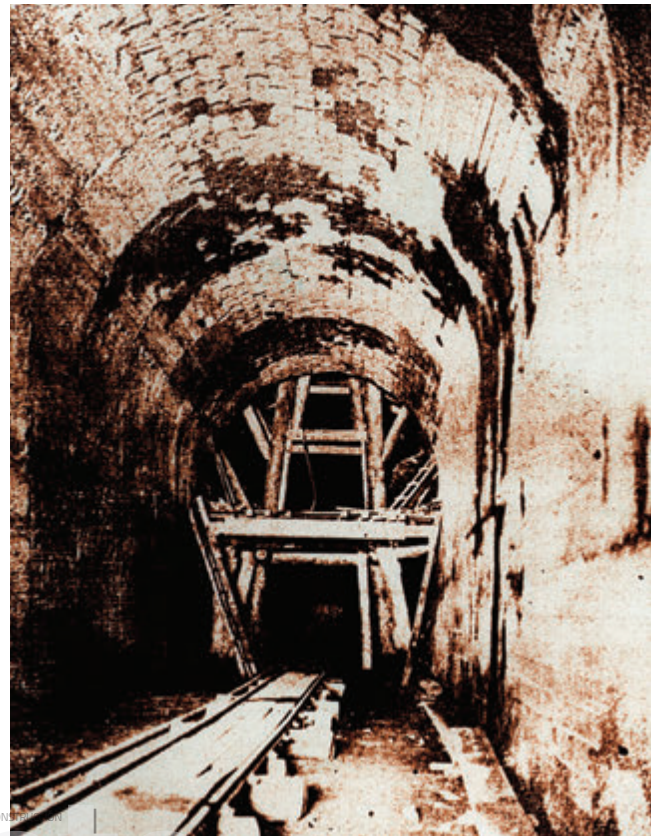
↑ Ferrocarril Ibagué - Armenia (1929). Gran Túnel de Calarcá; túnel en concreto vaciado y mampostería férrea.
