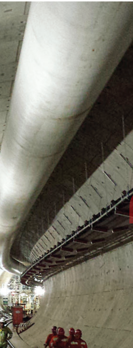
↑ Figura 1. Vista interna de túnel excavado con TBM y revestido con prefabricados de concreto.
