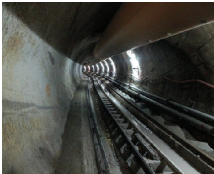
↑ Vista del túnel terminado, revestido con concreto.
