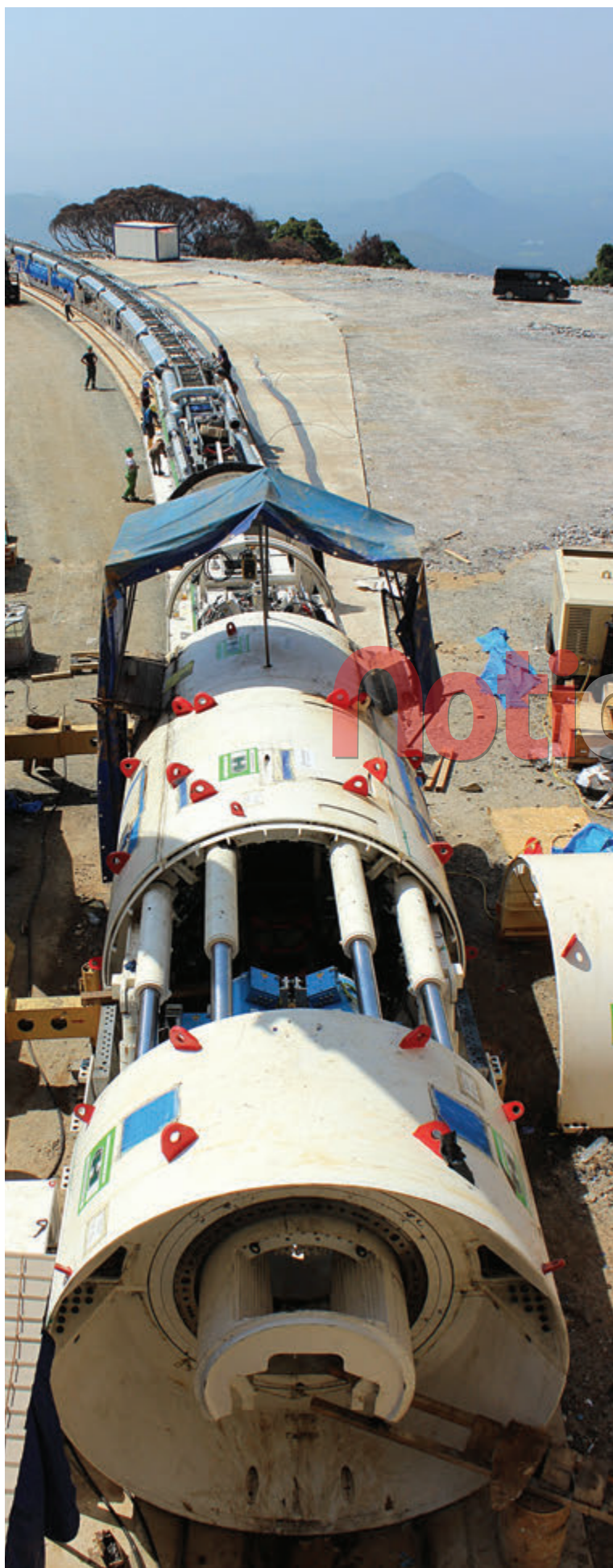
↑ Montaje del doble escudo TBM en obra.
