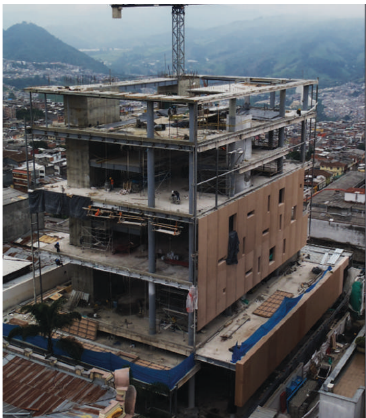
↑ Avance de la instalación de fachadas del Banco de la República en Manizales.
