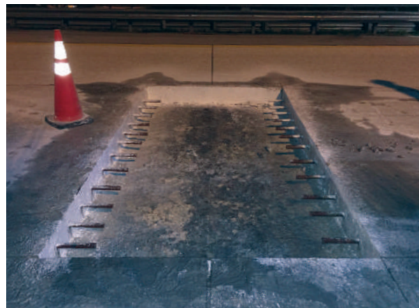
↑ Figura 8. Paso 5. Instalar las barras para las dovelas antes de fabricar los paneles de reemplazo.
