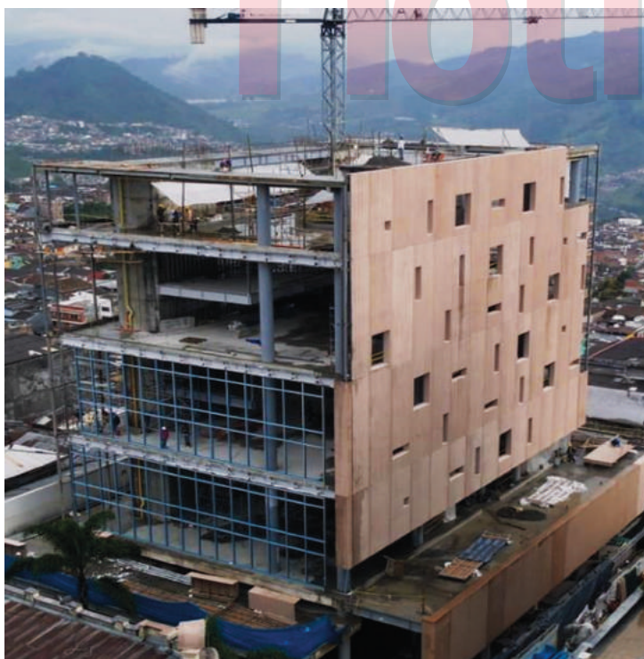
↑ Avance de la instalación de fachadas del Banco de la República en Manizales.
