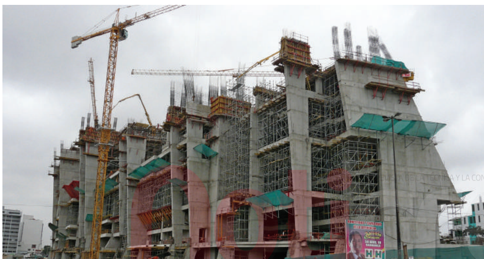
↑ El nuevo edificio de la UTEC está compuesto por muros y pórticos de concreto reforzado. FLICKR - ERNESTO OLIVERA
