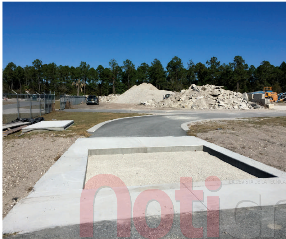
↑ Figura 4. Paso 1. Preparación de la sección de reemplazo.
