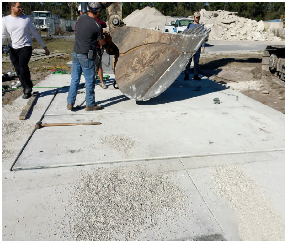
↑ Figura 5. Paso 2. Instalación de paneles prefabricados temporales de reemplazo en las secciones abiertas.
