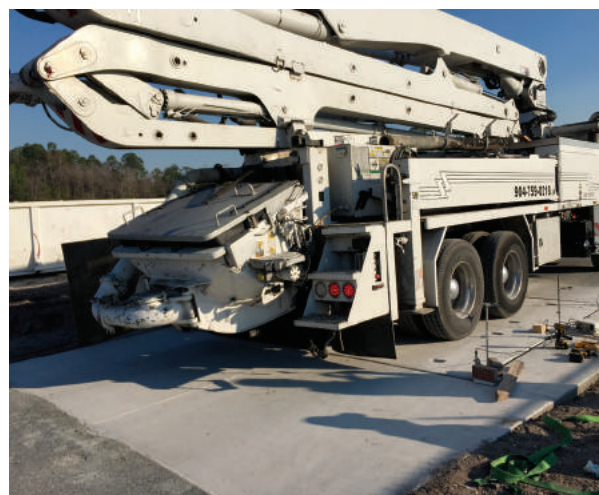
↑ Figura 6. Paso 3. Permitir el tráfico sobre los paneles temporales.
