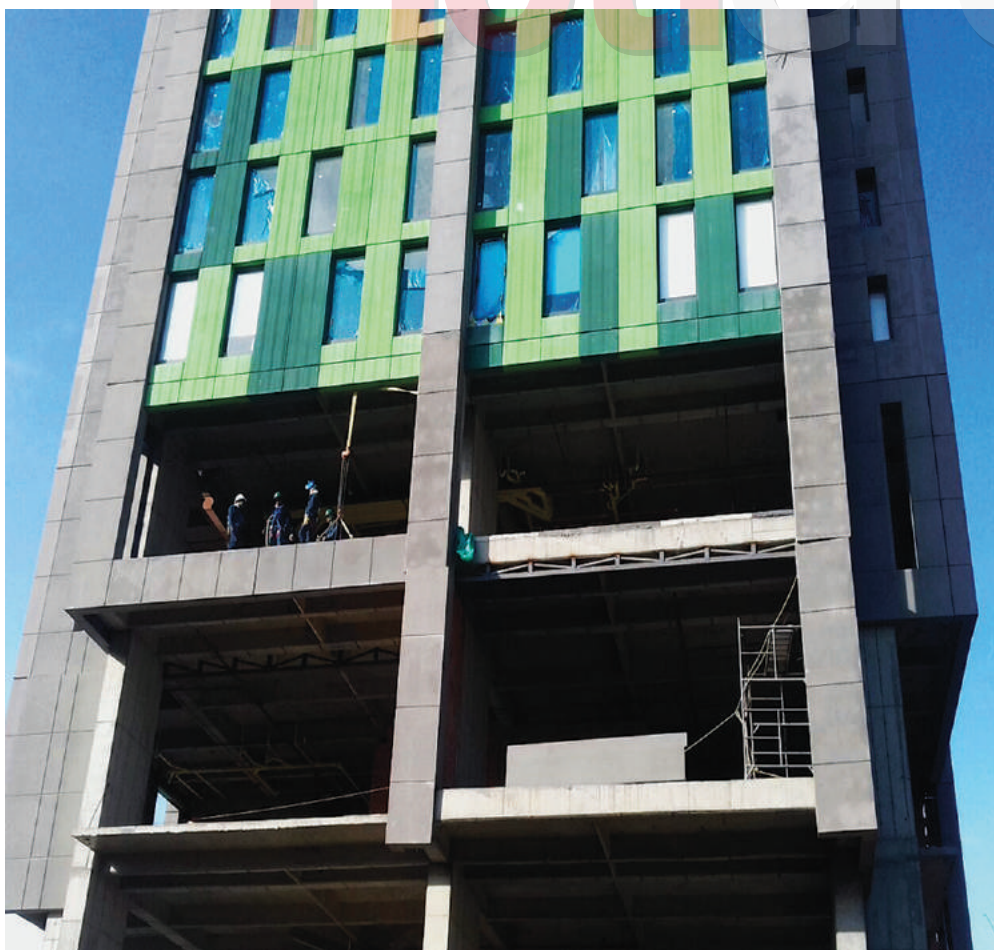
Proceso de instalación de paneles de GRC en el proyecto City U en Bogotá.
