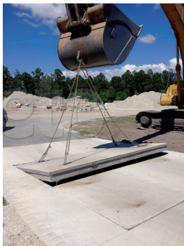
↑ Figura 7. Paso 4. Remover el panel temporal.
