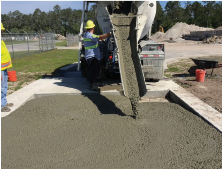
↑ Figura 9. Paso 6. Fabricación del panel de reemplazo con la mezcla SCC. No es necesario vibrar la mezcla.
